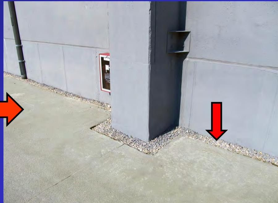
la mancanza di strato separatore ed elemento comprimibile perimetrale ha causato l'incisione dell'elemento di tenuta al piede del risvolto verticale
