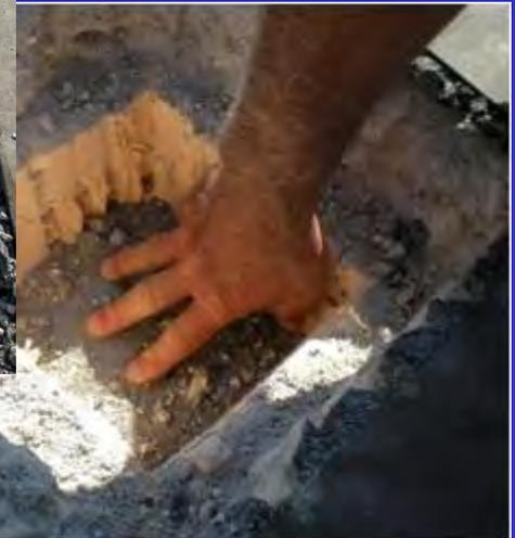
*sotto il massetto delle pendenze vi è una lama d'acqua di circa 10 mm*
