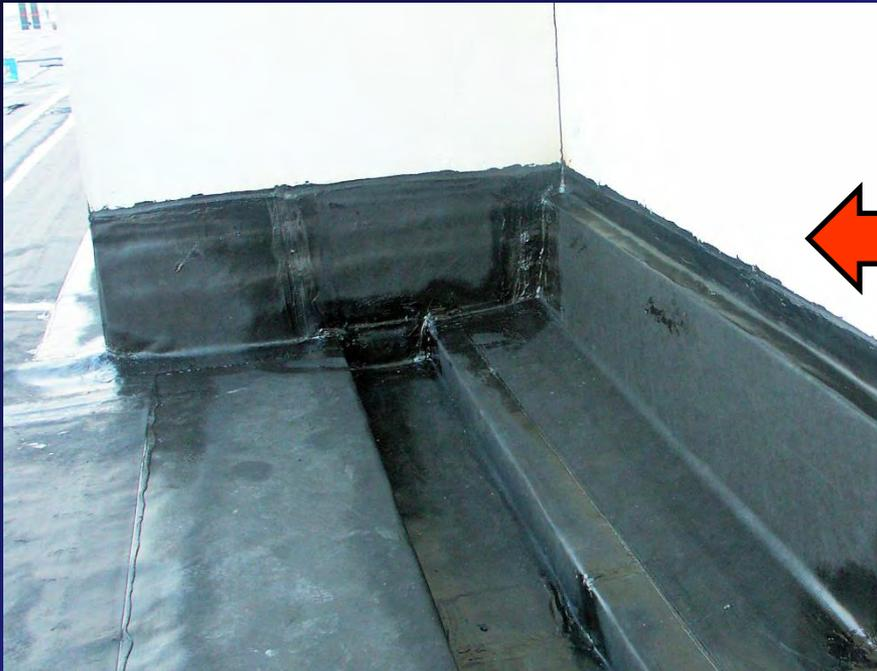
*Risvolto verticale in membrana sintetica con fissaggio al piede
