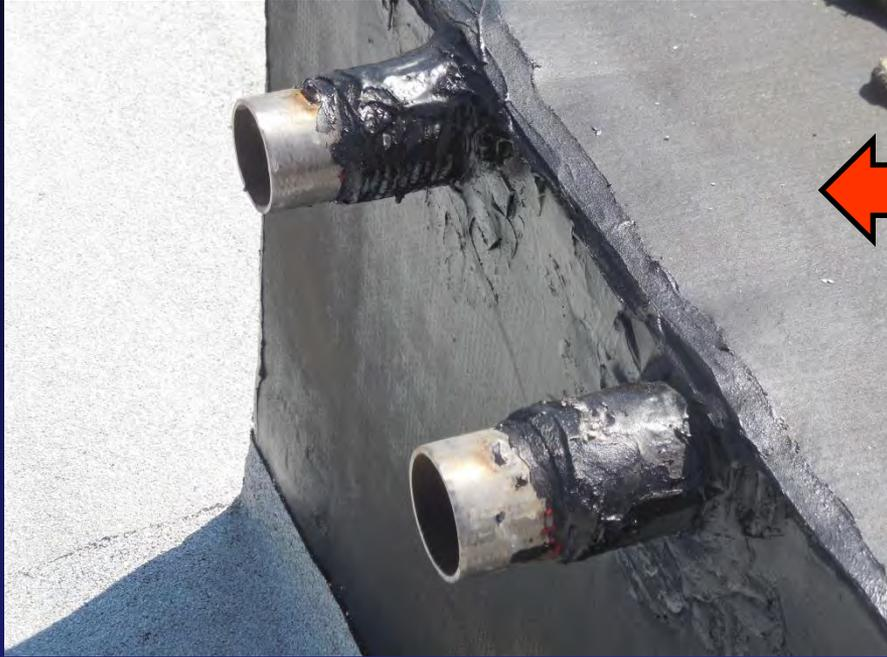
*Tubo passante un elemento di tenuta in membrane in bitume polimero*
